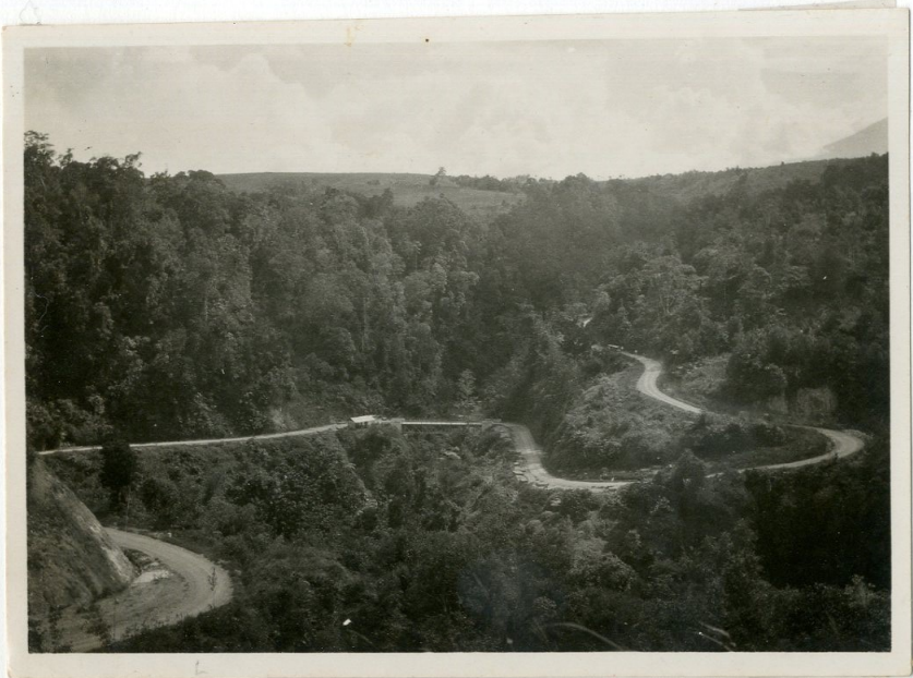
Overzicht Lematang ravijn met brug
