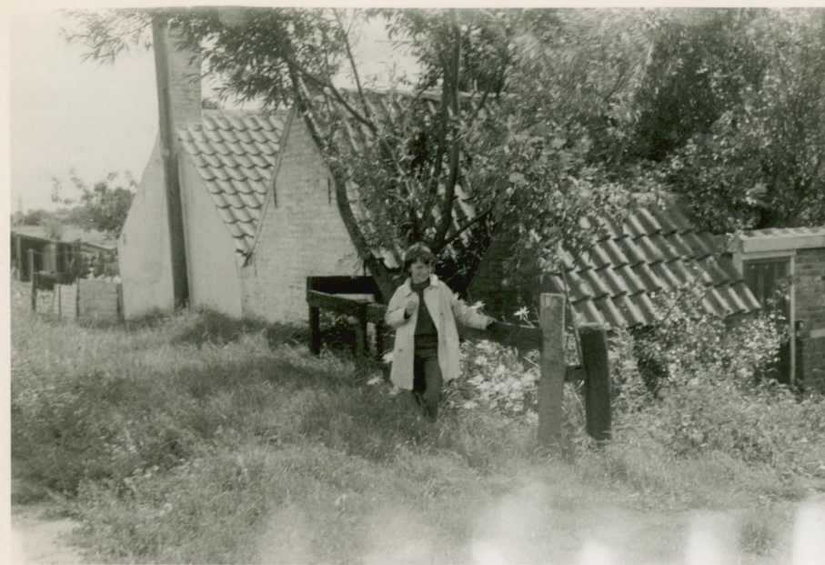
Boerderij - je aan de dijk.
